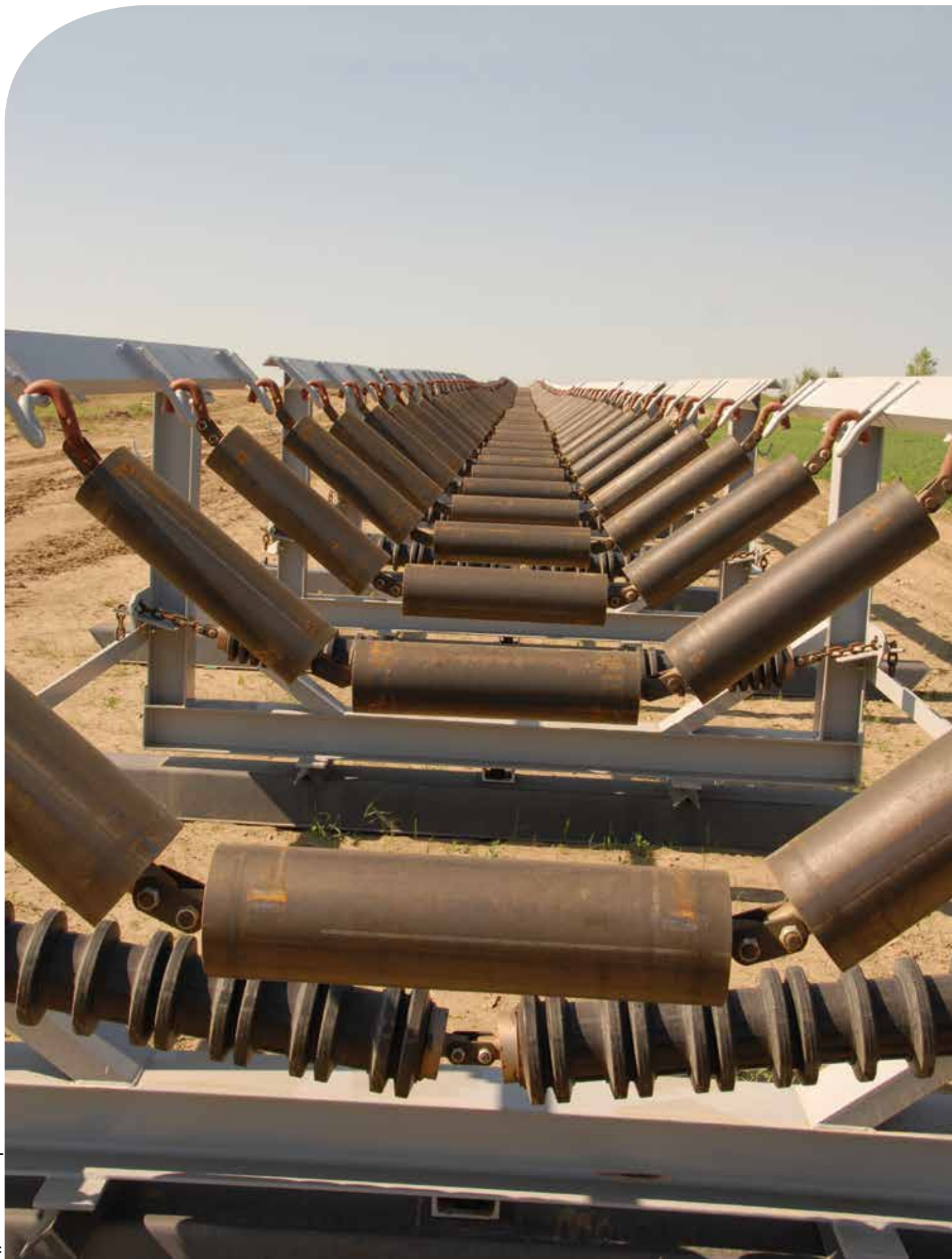
■ На Површинском копу „Дрмно“ у току је монтажа транспорта за шести јаловински систем. Дужина транспорта ће бити 12 километара.
